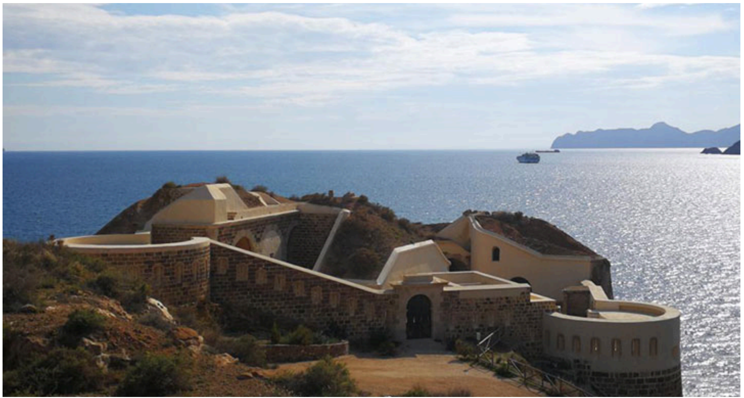
Bateria de Santa Ana Acamasatada en la actualidad.
